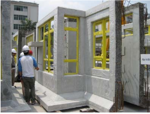
Fig. 1 Precast facades
